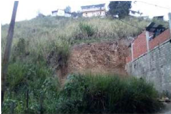
muestra en la Figura 6a. Además, como parte de la ampliación de las vías de comunicación hacia el sector La Meseta se realizan excavaciones que incrementan la susceptibilidad de la ladera aumentando así la probabilidad de riesgo del terreno como se muestra en la Figura 6b.
