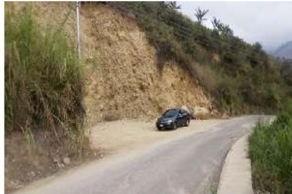
Figura 6. Desestabilización de taludes en el sector La Meseta: a) Deslizamientos por ampliación de viviendas; b) Excavaciones en torno a la vía de acceso.
