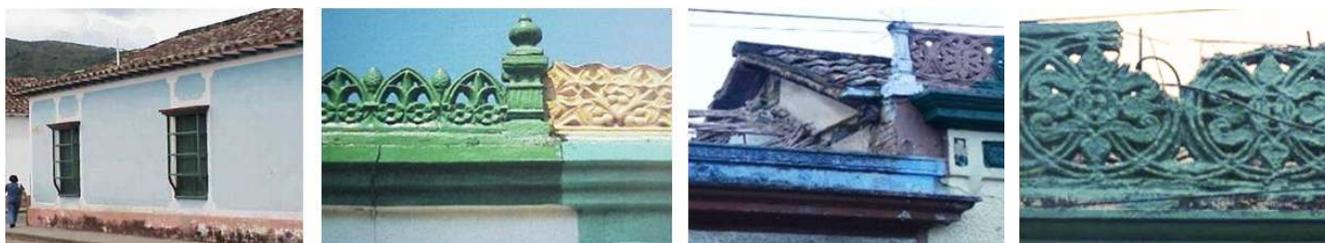
**Figura 5.** Transición del alero a la utilización de la cornisa en la cubierta inclinada, con una gran variedad de formas, alturas y elementos decorativos. Vivienda con cornisa prefabricada en la que sobresale el refuerzo metálico para su producción. Fuente: Villanueva (2017, p. 102).
