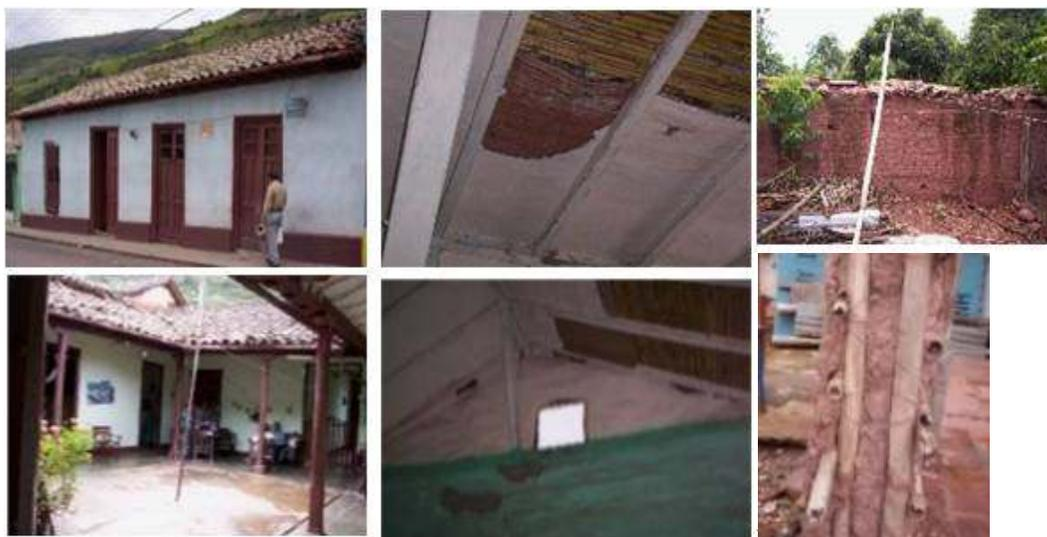
**Figura 6.** Fachada austera y patio central con corredores apoyados sobre columnas de madera. Cubierta en forma de cañón de par e hilera, revestida con enlucido de cal y yeso. Muro en tapia pisada en cerramiento externo del patio, y pared divisoria en bahareque en el área de la cocina. Fuente: Villanueva (2017, pp. 106 y 107).
