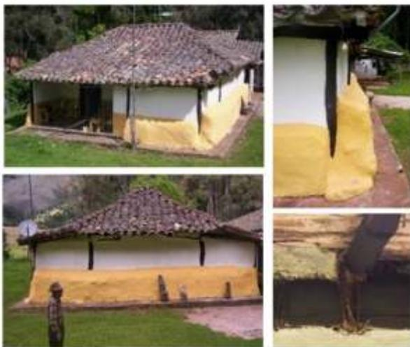
**Figura 3.** Fachada principal y lateral, sobresale el corredor, muro de piedra y cubierta cónica. Resaltan componentes de madera en la cubierta amarradas con bejuco. Fuente: Villanueva (2017, pp. 83 y 84).
