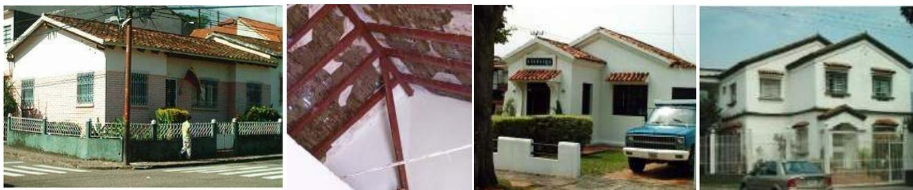
**Figura 8.** Vivienda del Banco Obrero en el Barrio Obrero de San Cristóbal, como vivienda para el sector popular, se evidencia la resolución de la cubierta de par e hilera de madera y esterilla de caña brava y cobertura de teja de arcilla cocida. Vivienda tipo Quinta en el Barrio Militar, cambia los aspectos formales y estéticos de la arquitectura tradicional. Fuente: Villanueva (2017, p. 146).
