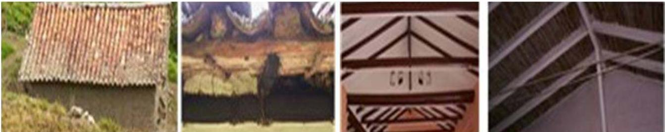
**Figura 4.** Cobertura en teja de arcilla cocida y componentes de la cubierta: viga solera, pares de madera rolliza, esterilla de caña brava, mezcla de barro y teja. Cubiertas de par e hilera en madera procesada con tirantes de madera y metálica, esterilla de caña brava y pie de amigo. Fuente: Villanueva (2017, p. 100).
