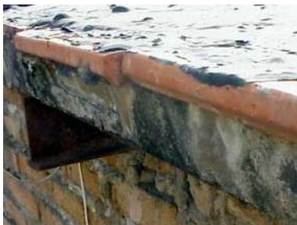
**Figura 10.** Detalle de la solución en la cubierta plana con loseta de arcilla cocida apoyada sobre el muro portante en ladrillo de arcilla. Fuente: Villanueva (2017, p. 132).
