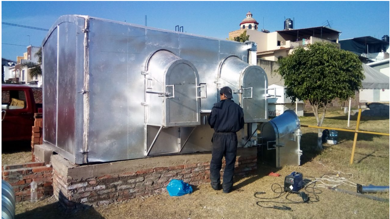
Figura 17. Horno cerámico sustentable para productos artesanales de arcilla en Latinoamérica, construido a finales de 2017 en el estado de Puebla (México), de acuerdo con las sugerencias de esta investigación.
