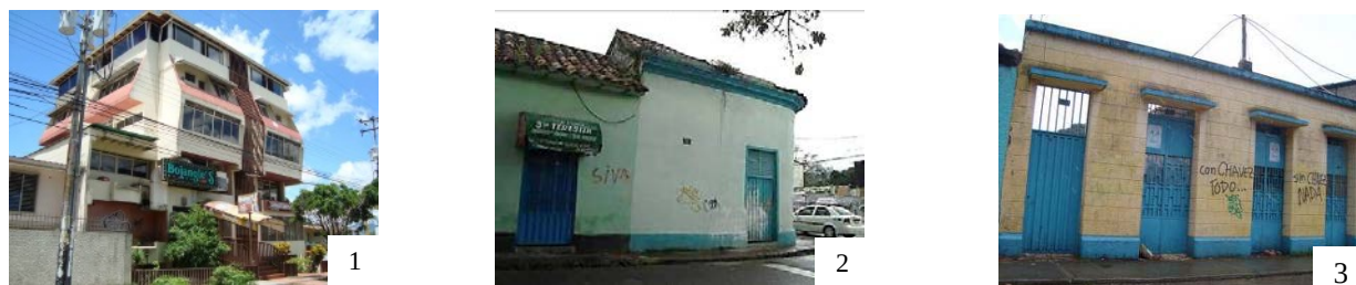
Figura 7. Edificaciones según el estado de la construcción: 1.-en buen estado, 2.- en regular estado, 3.- en mal estado; en el Sector de Barrio Obrero
