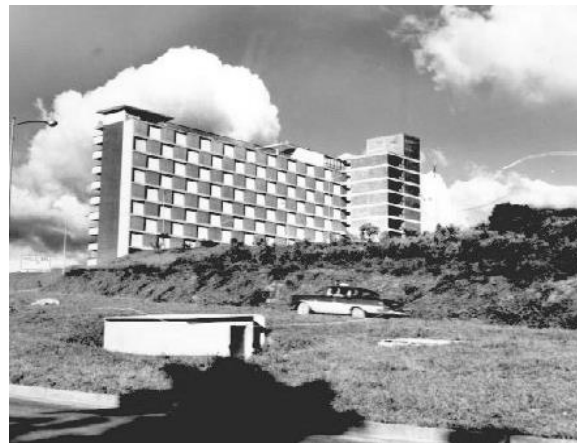
Figura 3. Hotel El Tamá, fachada sur y oeste del edificio principal, 1957.
