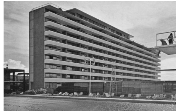
Figura 2. Hotel El Tamá, fachadas norte y este del edificio principal, 1957.
