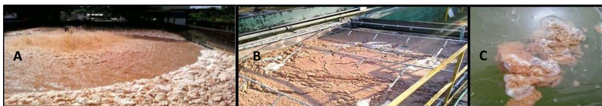
Figura 1. Panorámica del tanque de aireación (A) y la masa de lodos resuspendidos en el sedimentador secundario (B y C).
