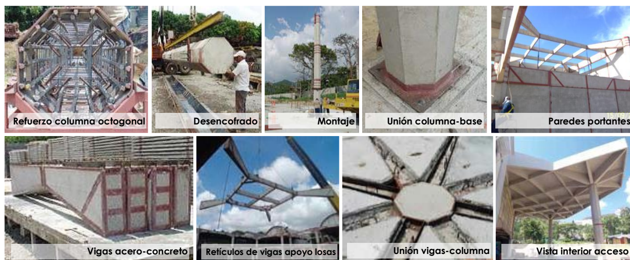
Figura 4. Imágenes de los componentes del sistema Concaprego (derivación) usados en la construcción de la Escuela Venezolana de Planificación.
