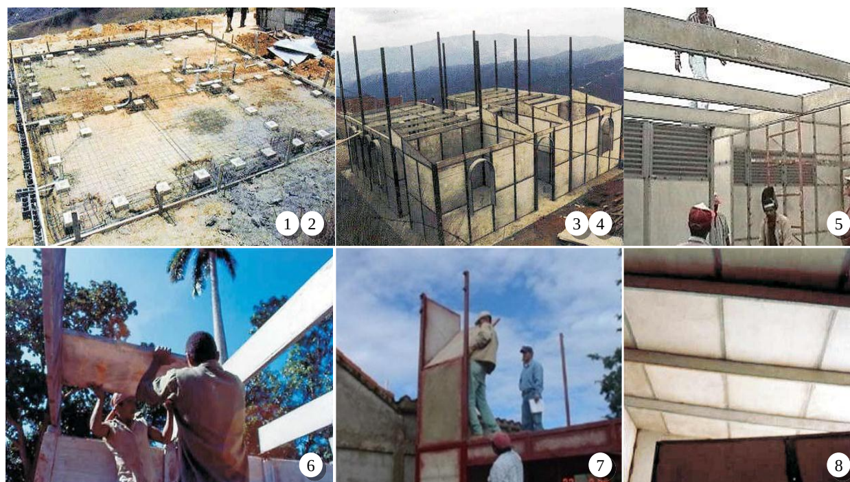
Figura 2. Proceso genérico de montaje del sistema Sancocho.
