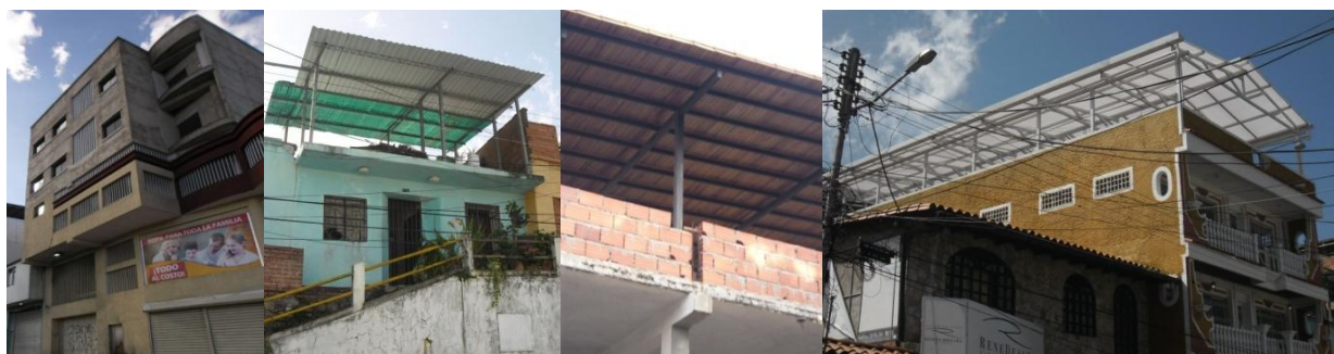
Figuras 5. Como cobertura del crecimiento se tiene una gran variedad de soluciones: losa de concreto, lámina metálica liviana con mayor predominio, machimbre con teja y lámina traslúcida.
