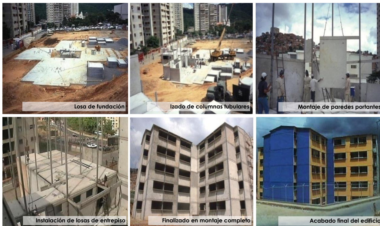
Figura 3. Proceso constructivo de un edificio de cinco pisos ejecutado con el sistema Concaprego.
